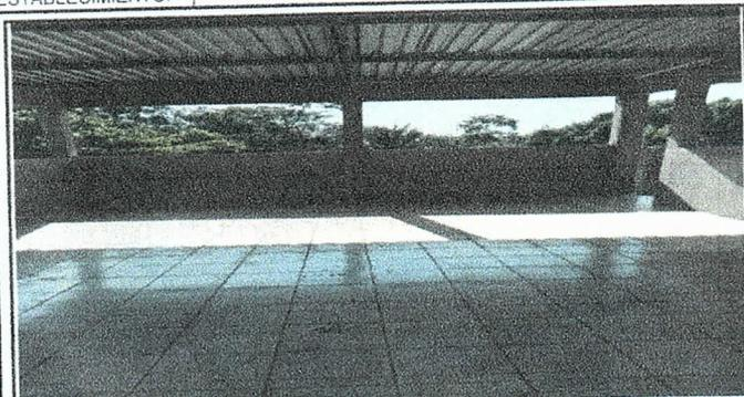
Foto 7: Se sustituyó lámina perforada por lámina troquelada Aluzinc calibre 26 con elementos de fijación.
