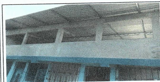
Foto 11: Muro perimetral de block de 32 metros x 1.60 en aula del segundo nivel.
